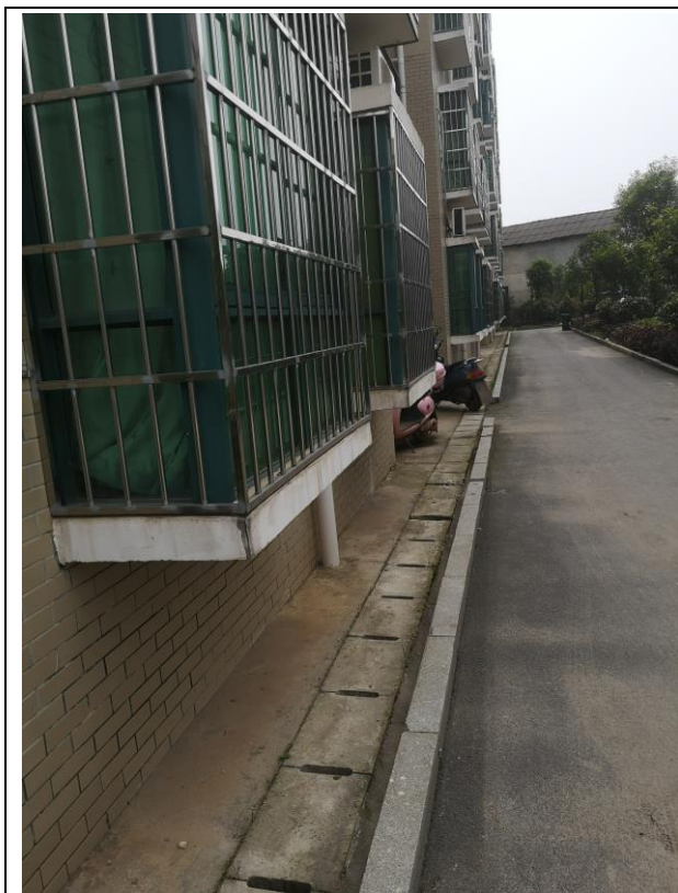
建筑物周边排水沟
