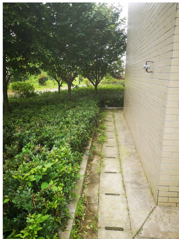
建筑物周边排水沟
